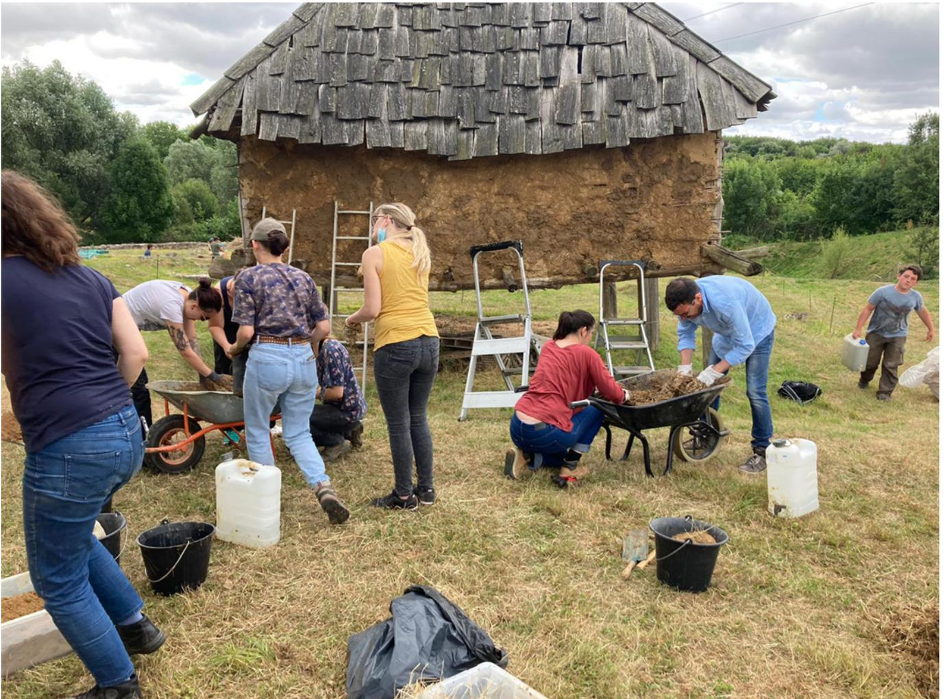
Figure 3.38 – Préparation du torchis et travail collectif pour la réfection du grenier.
