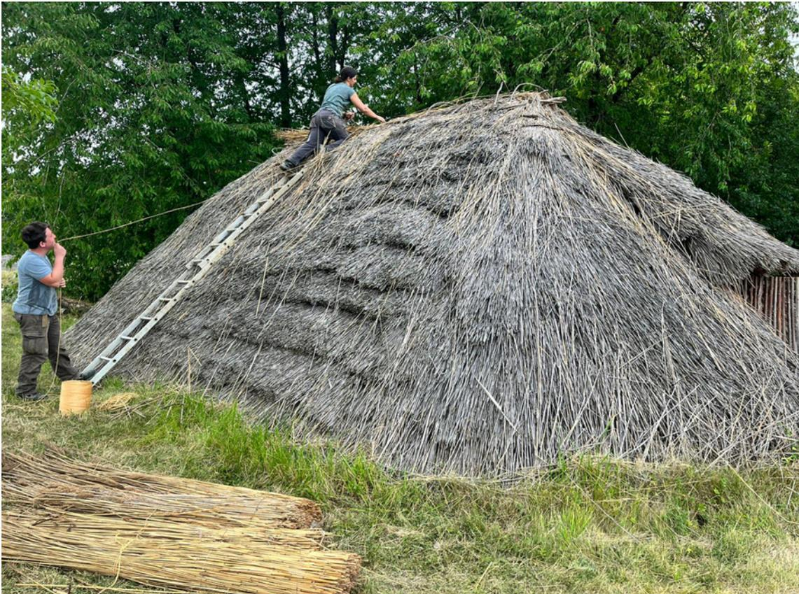
Figure 3.41 – Réfection du faîtage de la loge-cellier
