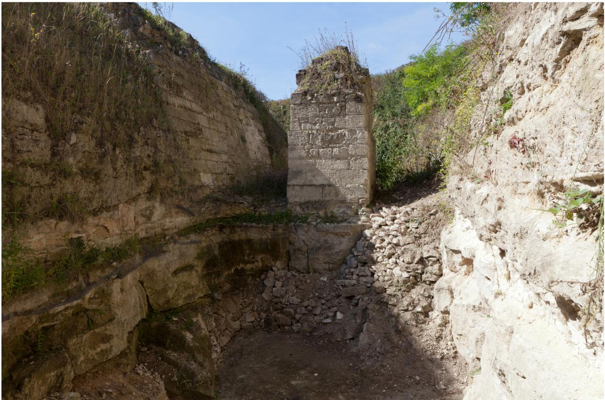
Figure 5.9 – Photographie depuis l'est de la pile du pont-levis et du fossé nord en 2011. on voit clairement les différents niveaux de calcaire et le niveau du premier creusement, s'arrêtant sur les niveaux de calcaire les plus durs, au nord et au sud de la pile, qui repose sur ces niveaux.
