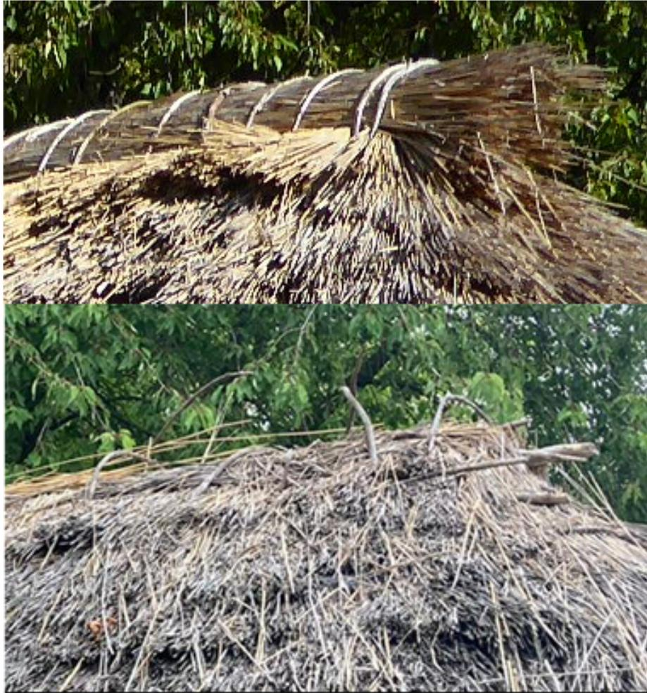
Figure 3.42 – faîtage de la loge-cellier. En haut : en 2014. En bas : en 2022. Les arceaux de noisetier, placés en force pour maintenir les roseaux, se sont brisés une fois secs.
