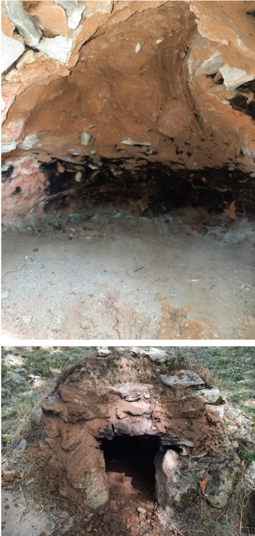
Figure 3.44 – État de l'intérieur de la voûte du four (en haut) et colmatage des trous à l'extérieur de la voûte, avec des pierres liées au limon (en bas).
