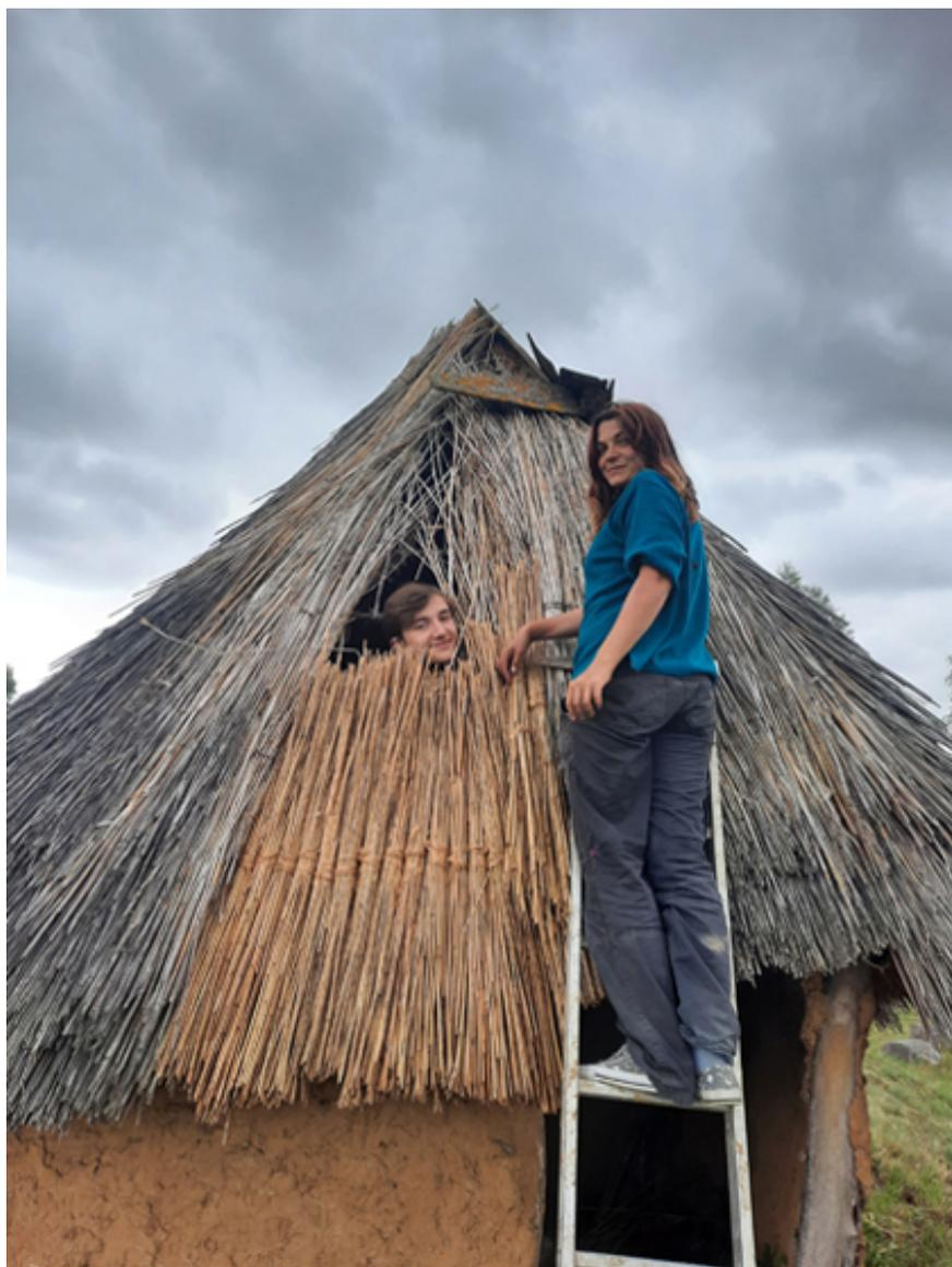
Figure 3.32 – Réparation du couverture de la cabane de tisserand en cours.
