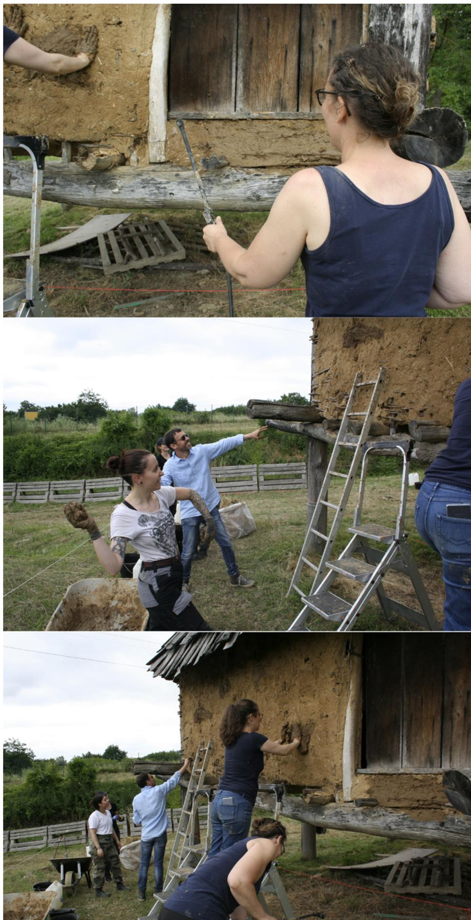
Figure 3.37 – Application du torchis sur les parois du grenier. De haut en bas : humidification des parois, composition de boules lancées sur les parois, lissage du torchis sur les parois.
