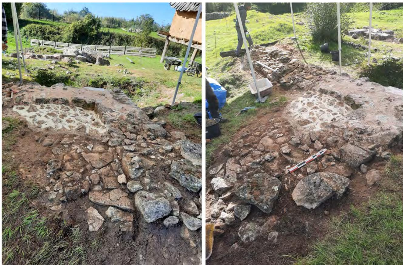
Figure 6.5 – Zone 5 : vue du fragment de sol remis au jour dans l'angle nord-ouest du bâtiment est. La restauration a été entamée, dans l'angle, avec un mortier rose recouvert d'un badigeon de chaux.
