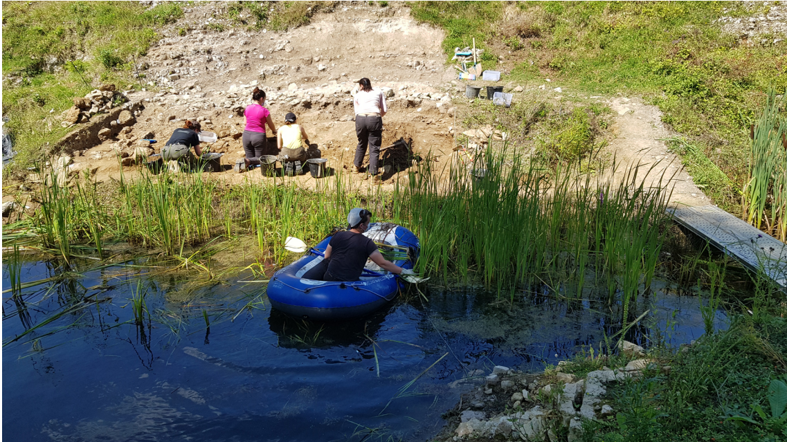
Figure 3.15 – Retrait des roseaux ayant poussé dans le fond du fossé.
