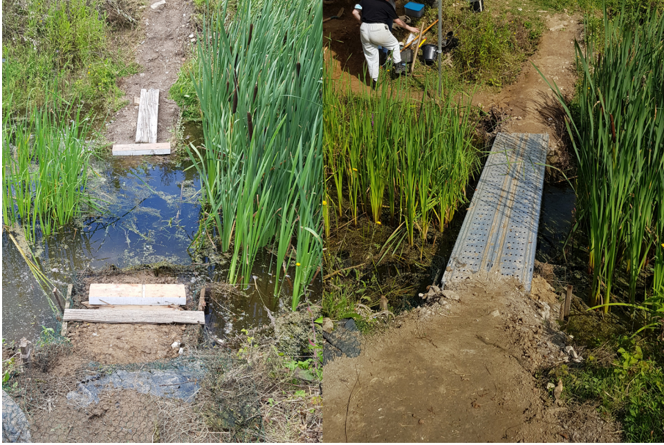
Figure 3.5 – Construction d'une passerelle pour accéder à la zone de fouille
