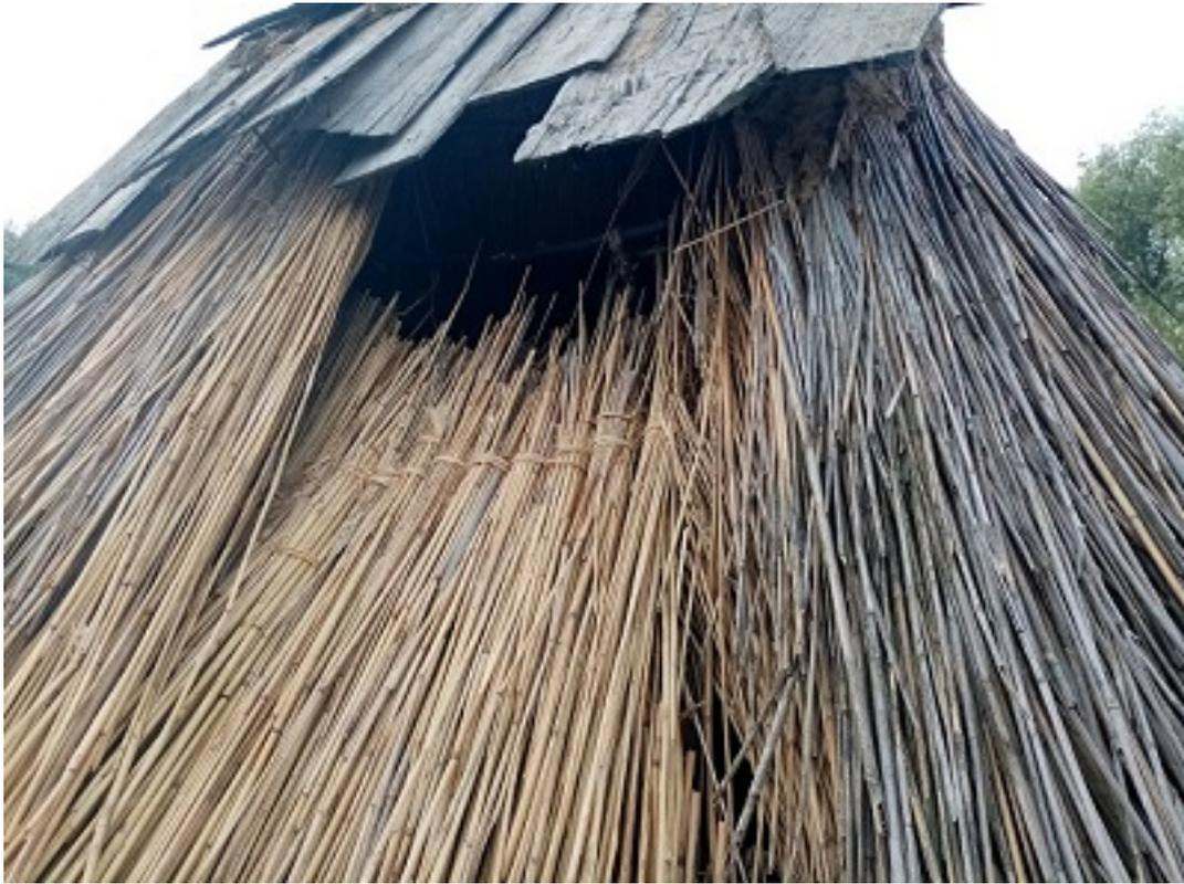
Figure 4.16 – Vue extérieure de la restauration du couvrement de la cabane de tisserand.
