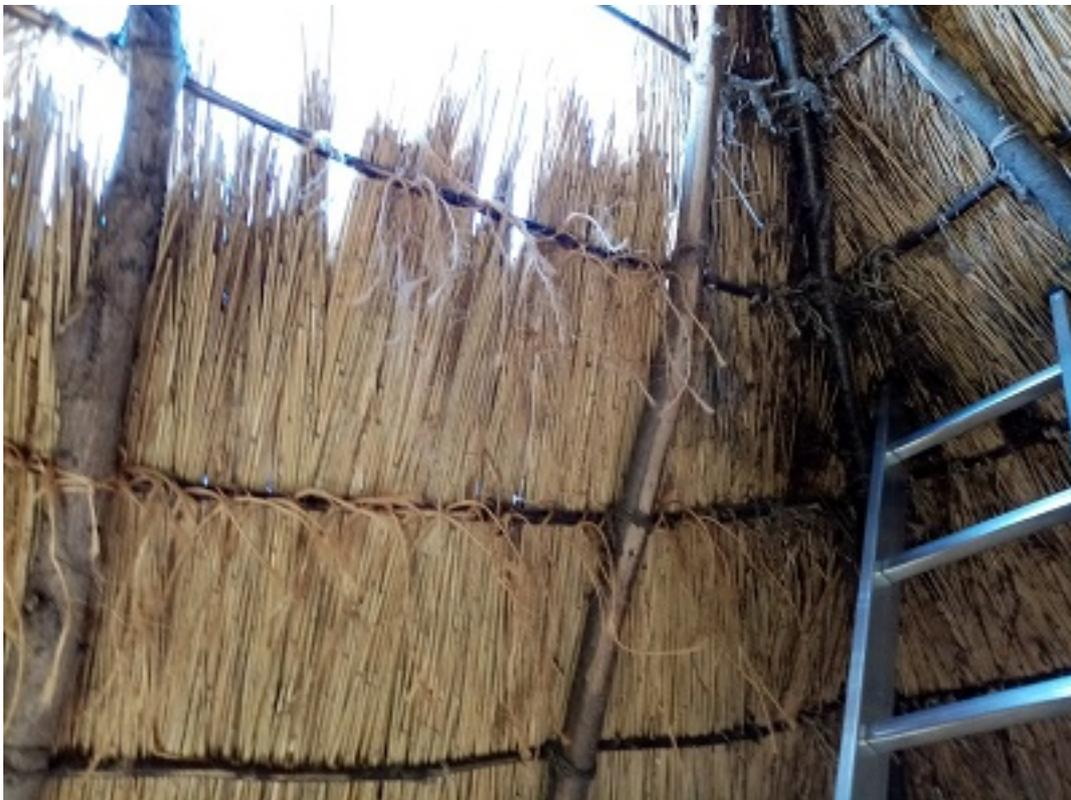
Figure 4.17 – Vue intérieure des ligatures du réalisées pour le couvrement de la cabane de tisserand.
