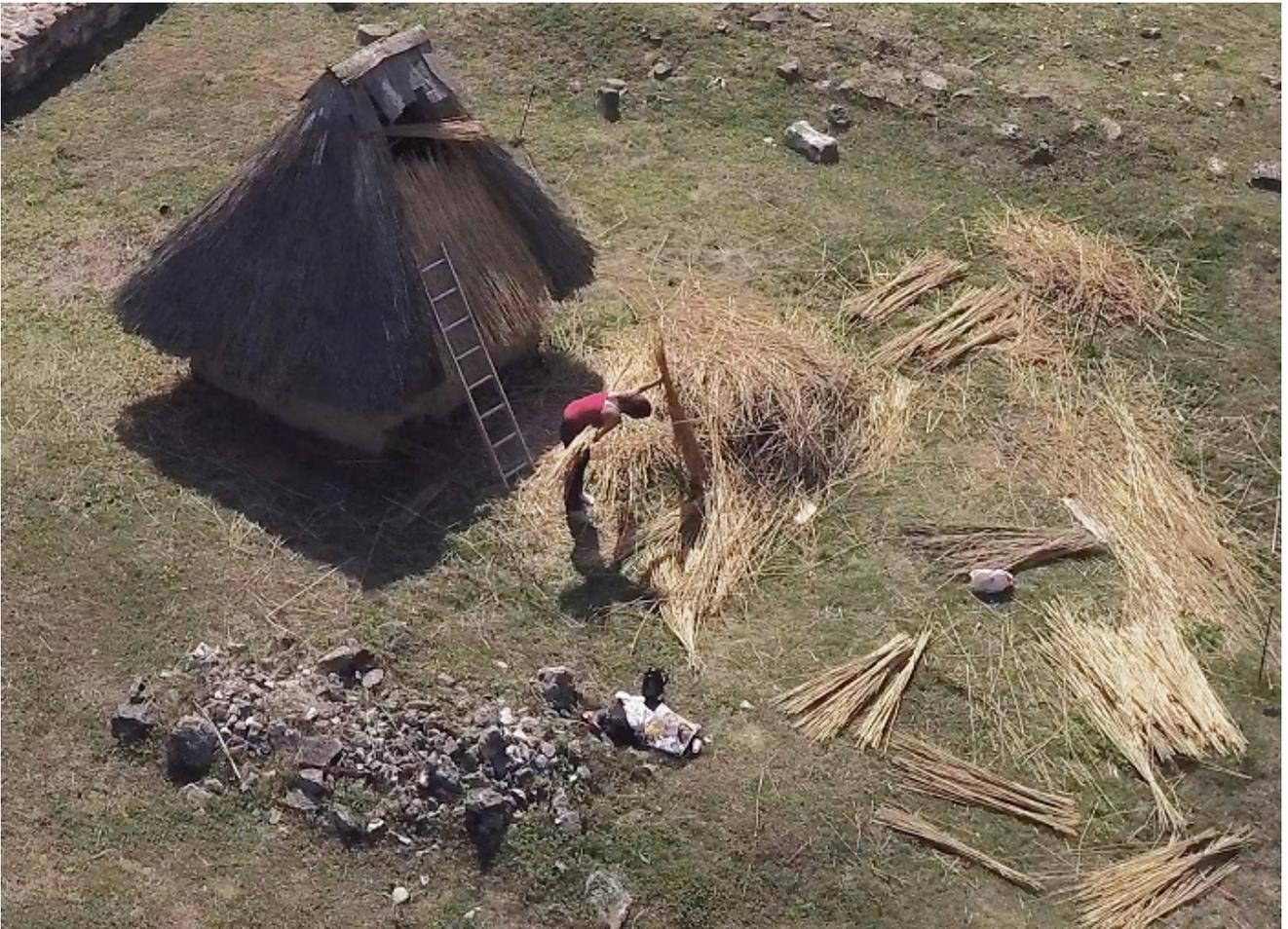
Figure 4.15 – Vue aérienne de la réfection du couverture de la cabane de tisserand.
