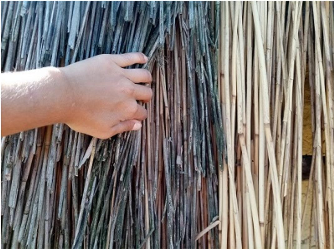
Figure 4.18 – Comparaison entre le nouveau et l'ancien couverture. Sur les parties non restaurées, on voit l'effet de pourrissement des roseaux de section fine, les parties les moins exposées étant relativement préservées.
