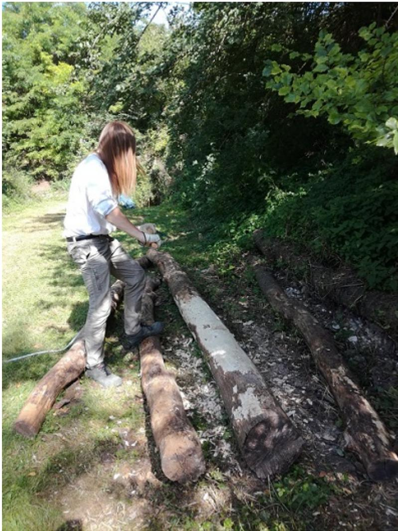
Figure 4.7 – préparation à la hache de deux poteaux et d'une sablière stockés sur le site depuis 2015.
