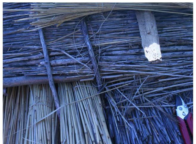
Figure 4.1 – Réparation du chaume sur le bâtiment semi-excavé.
