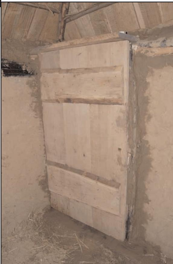
Fig. 14 : Colmatage du bâti dormant au torchis
