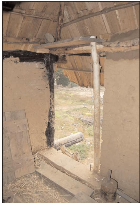
Fig. 12 : Réalisation du bâti dormant de la porte
