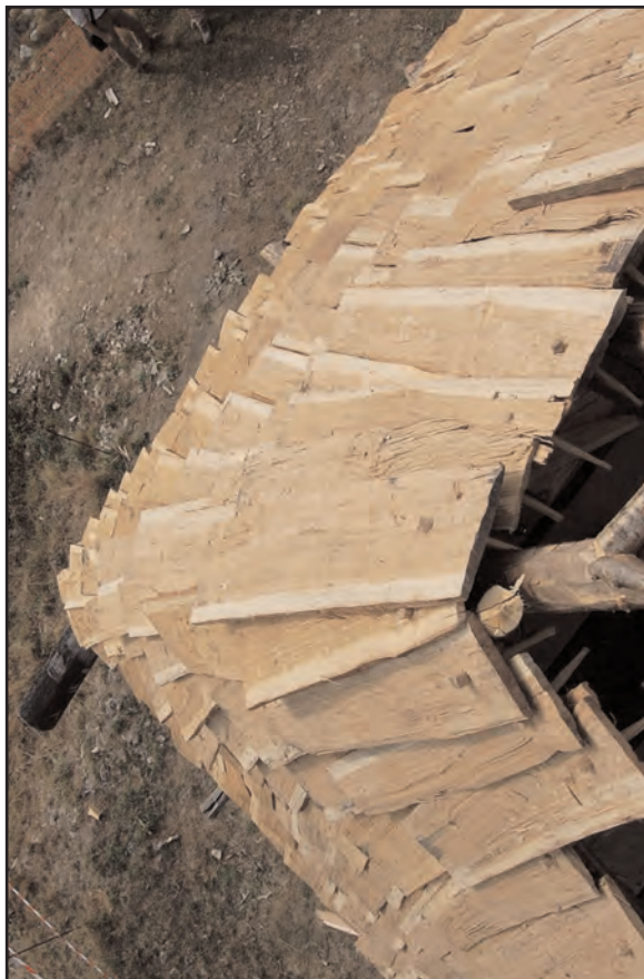
Fig. 11 : arêtier réalisé par recouvrement latéral des bardeaux
