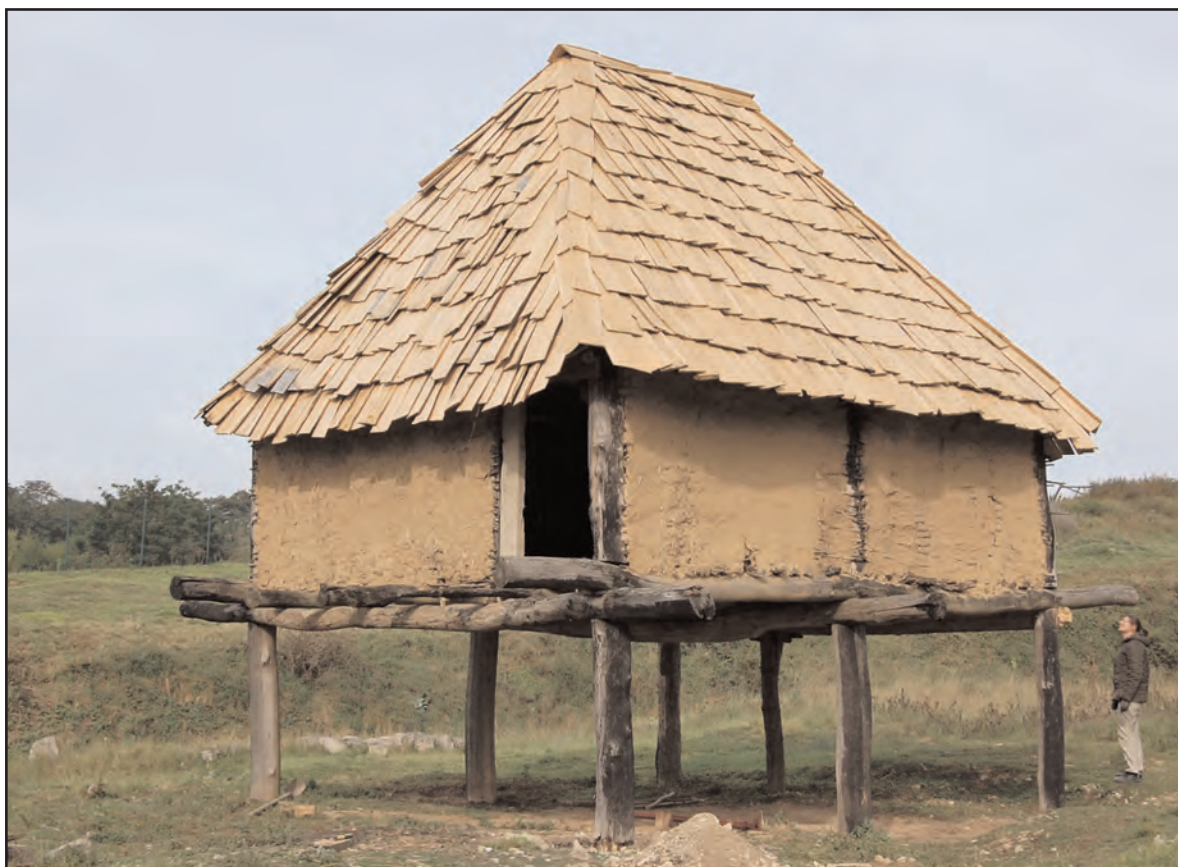
Fig. 17 : vue sud-est du grenier avec sa couverture en bardeaux
