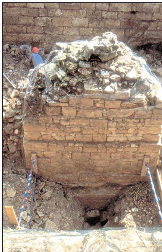
Fig.55 : partie arrière de la pile en 2001
