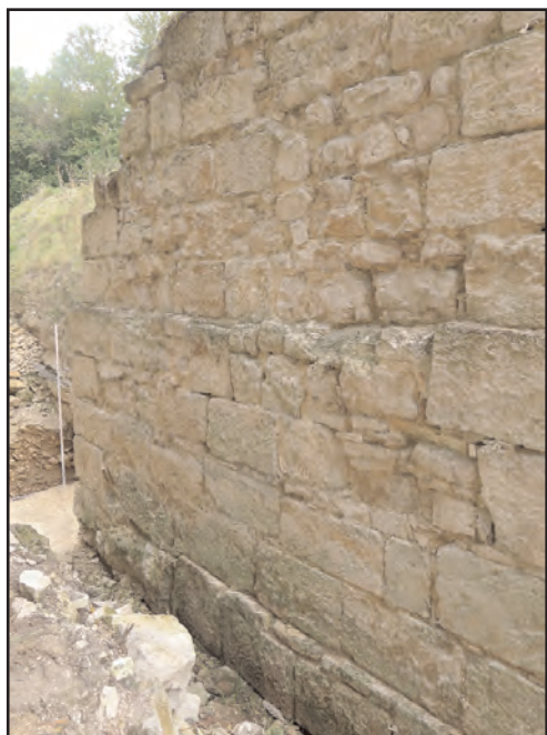
Fig.56 a et b : partie arrière de la pile en 2011
