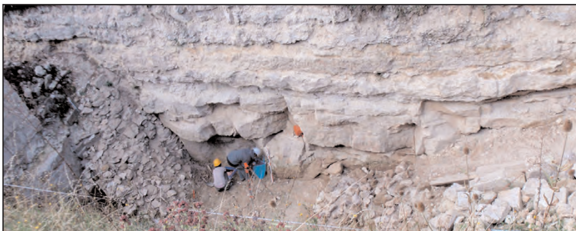
Fig.59 : vue de l'escarpe au nord-ouest de la pile.
