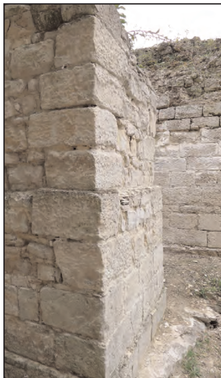
Fig.57 : redégagement de la base de la maçonnerie sur la partie arrière de la pile, celle-ci avait dégagée de façon éphémère en 2001 et comblée ensuite afin de ne pas risquer de déboîter la pile..
