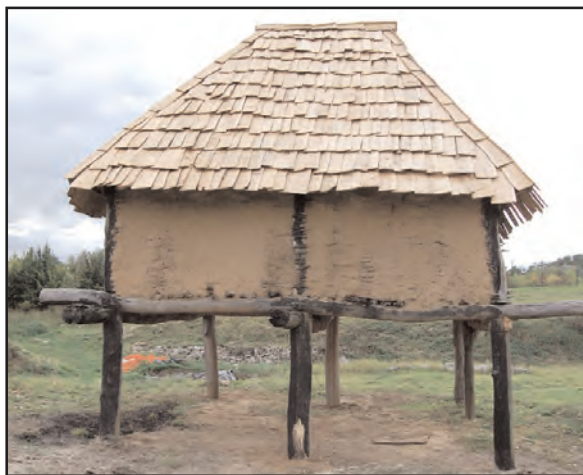
Fig. 16 : vue est du grenier achevé
