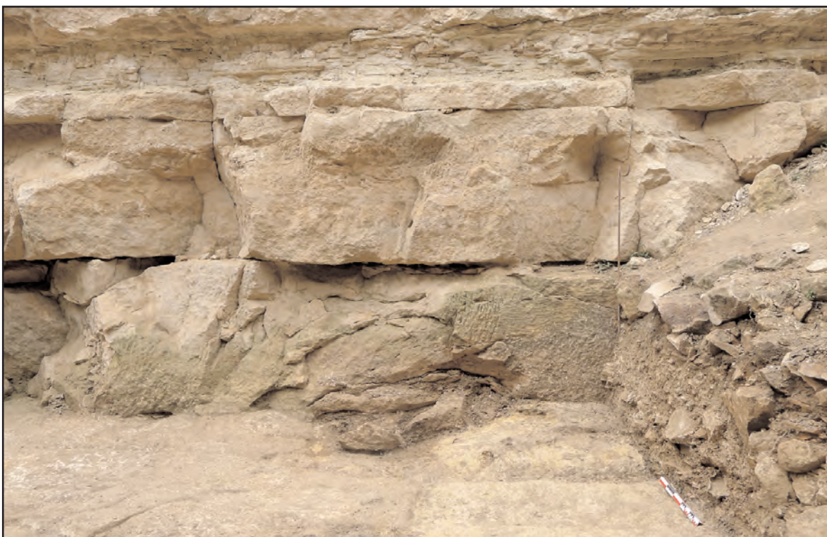
Fig.67 : Ensemble de tranches de défermage et d'éclatements sur fissures tectoniques
