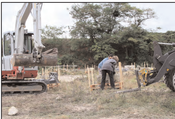
Fig.123 : mécanisation des déplacements de blocs
