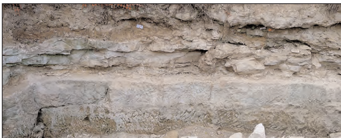
Fig 74 a et b : Longue tranche de défermage. Le bas du bloc, éclaté, a été retaillé au pic pour régulariser le flanc du fossé.
