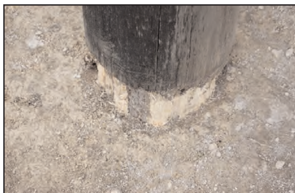
Fig. 23 : comblement par les terres de surface du vide laissé par la perte de l'aubier
