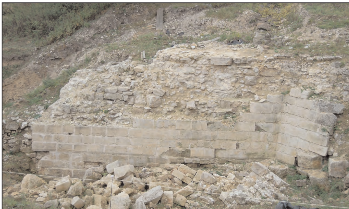
Fig. 119 : état de l'ouvrage sud-est (porte) Le rejointoiement des blocs effectué systématiquement depuis 2008 allié à un bon drainage a permis une conservation satisfaisante du mur. Aucun élément n'a été rajouté.
