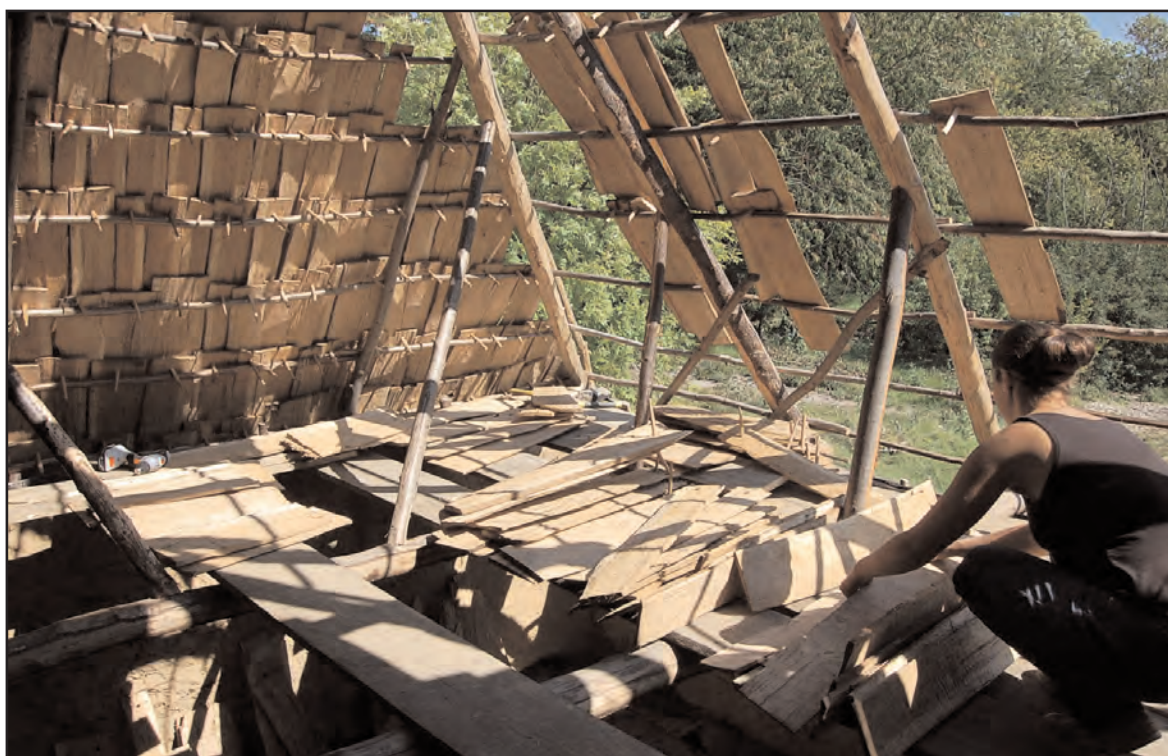
Fig. 10 : stockage des bardeaux sur le plancher provisoire au niveau des entrails
