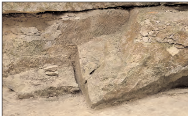
Fig.71b : Abattage raté d'un bloc : défermage et flanc sur fissure tectonique
