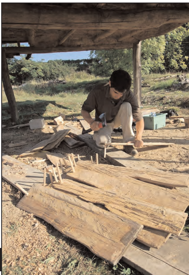
Fig. 9 : fixation des chevilles dans les bardeaux
