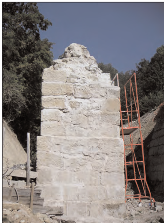
Fig. 122 : rejointoiement de la pile en 2004
