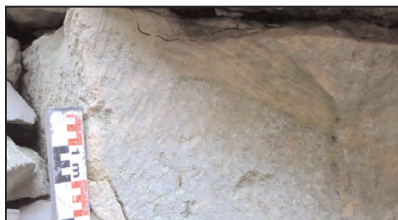
Fig.69 : tranche de défermage : extrémité de l'encoignure.
