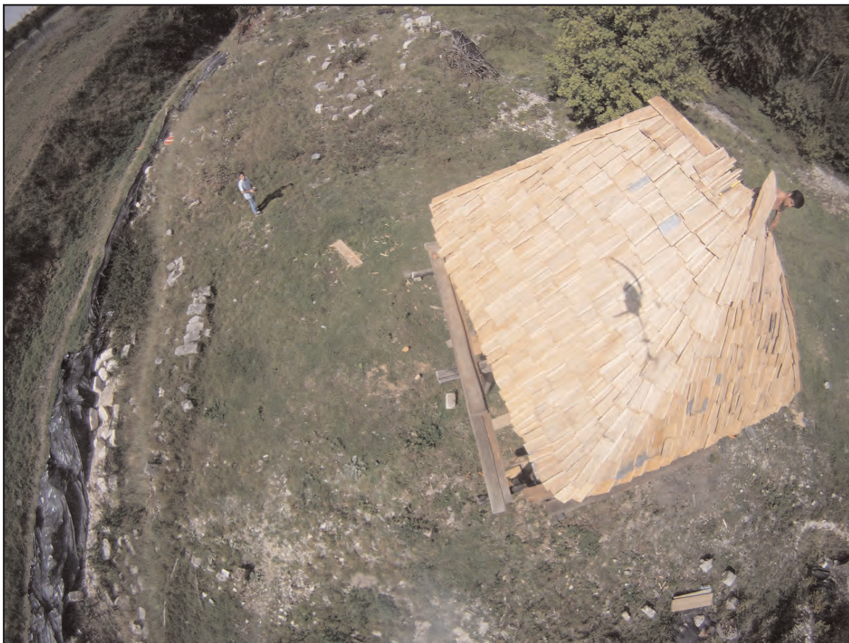
Fig.3 bis pose du dernier bardeau de l'arêtier
