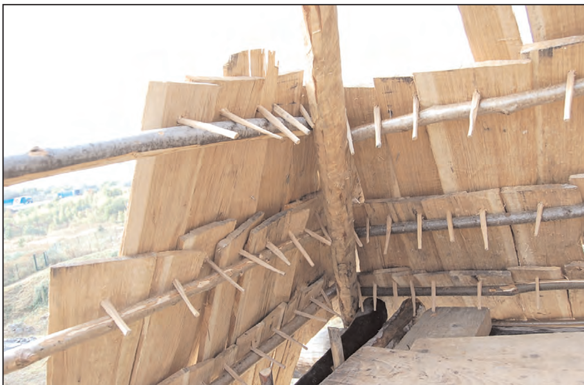
Fig. 4 : mode de fixation des bardeaux par chevillage travaillant en butée sur le lattis
