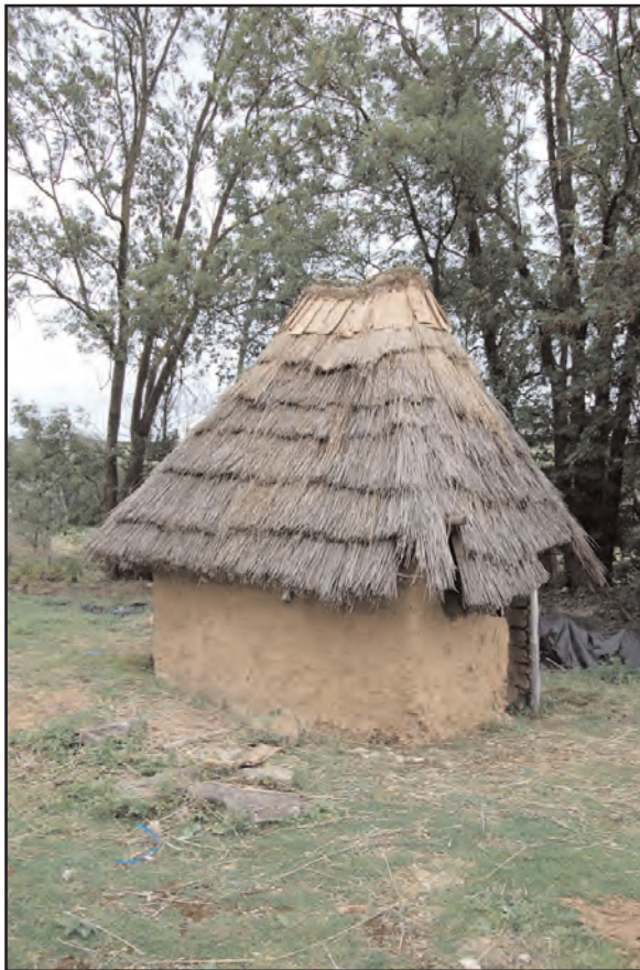
Fig. 28 : toiture et faitage achevés
