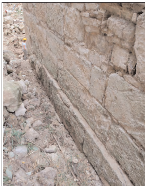
Fig.57 : redégagement de la base de la maçonnerie sur la partie arrière de la pile, celle-ci avait dégagée de façon éphémère en 2001 et comblée ensuite afin de ne pas risquer de déboîter la pile..
