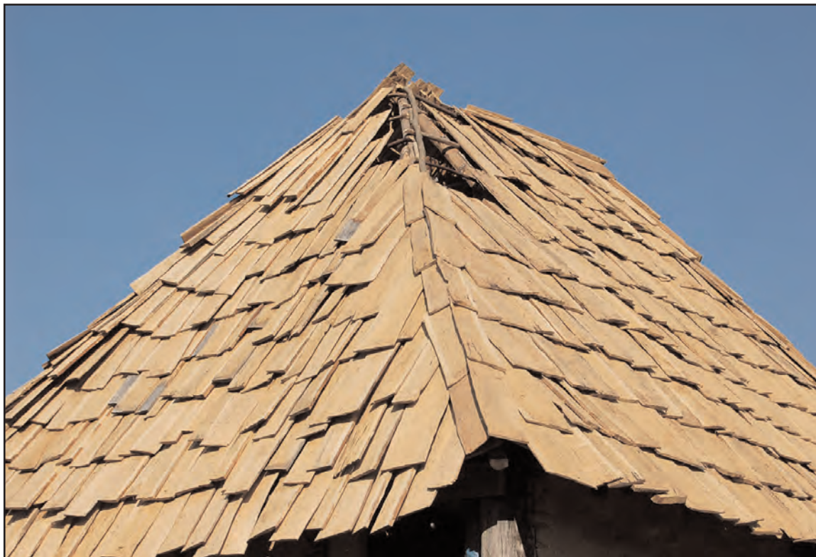
Fig. 14 : arêtier en cours de réalisation
