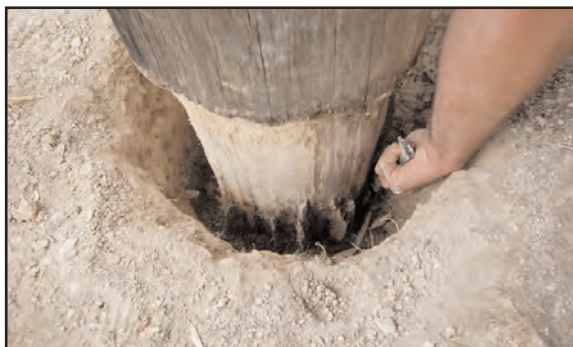
Fig. 22 : vue en profondeur du poteau avec le cœur du bois bien conservé
