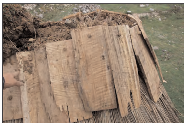
Fig. 26 : recouvrement des liens par des bardeaux
