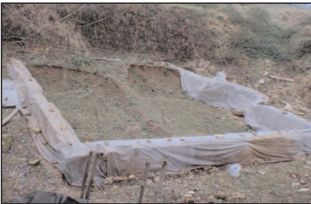
Fig.130 : protection de la fontaine par la pose d'un bidim et de bâches durant l'hiver 2010-2011
