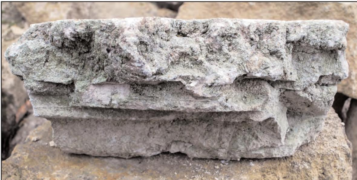
porte la trace en négatif d'une baguette de bois longitudinale dont la fonction reste indéterminée et le plâtre de la moulure proprement dite, plus fin que celui de la maçonnerie et portant des traces encore visible du tirage au calibre.
