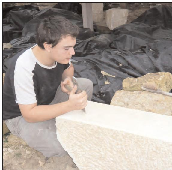
Fig. 113 : finition d'un carreau
