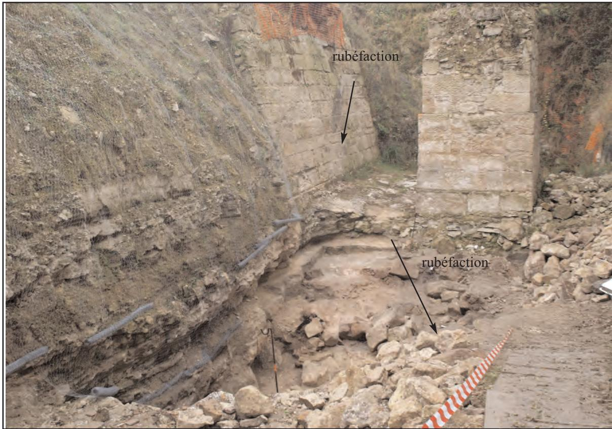
Fig. 33 : parties rubéfiées par la combustion d'éléments de la porte et du tablier du pont-levis
