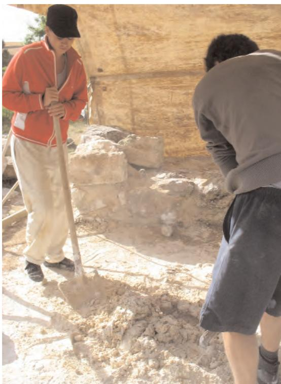
Fig. 112 : corroyage du mortier de chaux sur le chantier
