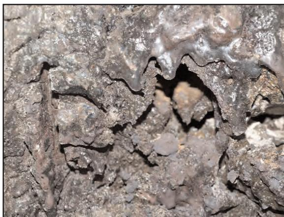
Fig. 94 : scorification des parois à l'emplacement de la tuyère
