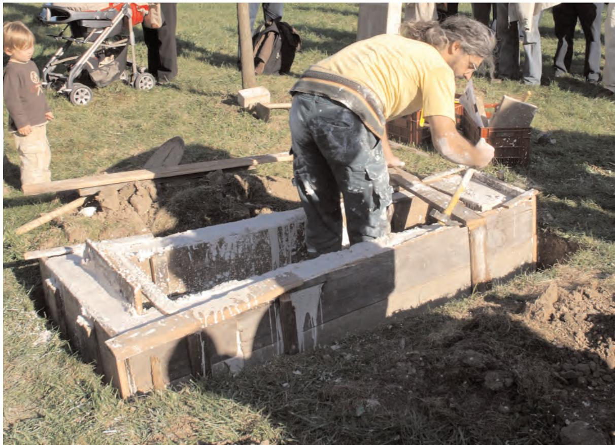
Figure 107 : Démontage du moule après la coulée de la cuve, ph. A. Nice (cg02).
